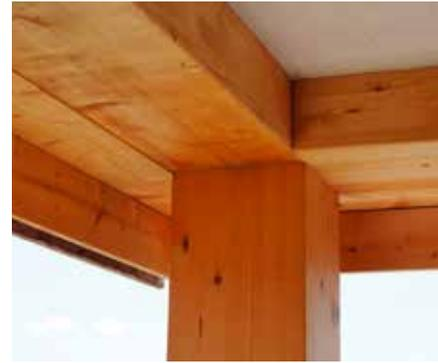
**Anschlusspunkt zwischen einer Holzstütze und den Holzbalken der Pfosten-Riegelkonstruktion in den oberen Gebäudageschossen: Aus ästhetischen Gründen wurden die Stützen und Balken überall mit einem einheitlichen Querschnitt von 28 x 28 cm ausgeführt**
