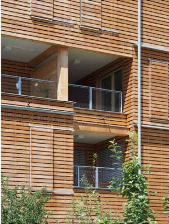
die Fassaden größtenteils im Werk fertiggestellt, das heißt die Fenster und Schiebeläden bereits im Werk montiert. Auf diese Art und Weise mussten auf der Baustelle nur die Eckverbindungen beziehungsweise die Geschosstöße geschlossen werden.
