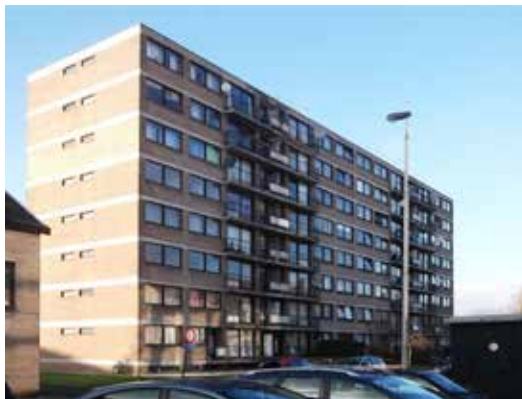
Der Bestandsbau aus den 1960er-Jahren steht auf dem ehemaligen Gelände einer Farbenfabrik. DBLV architecten haben ihn umgebaut und um zwei Neubauten ergänzt
