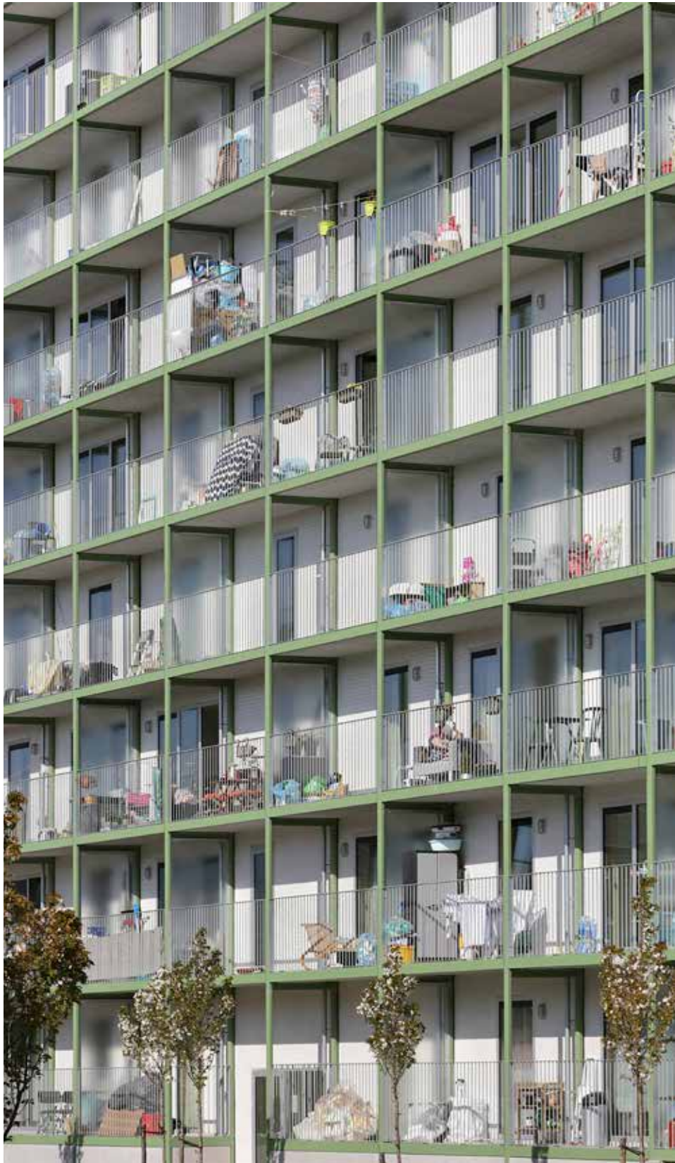
Die neuen Fertigteilbalkone an der Westseite des Bestands fügten die Planer:innen als separate Tragkonstruktion hinzu. Dafür bedurfte es einer Ausnahmeregelung der Baubehörde
