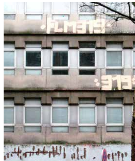
Ungesäuberte Bestandsfassade Rue de Mouzaïa Nr. 58
