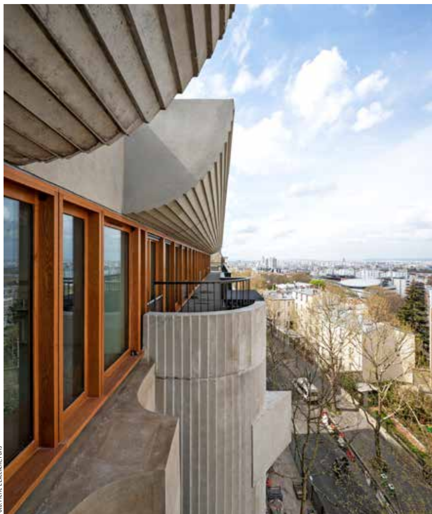
Sanierte Fassade des Dachgeschosses Rue de Mouzaïa Nr. 58 mit ihren speziellen Betonbauteilen und den neuen Fenstern
