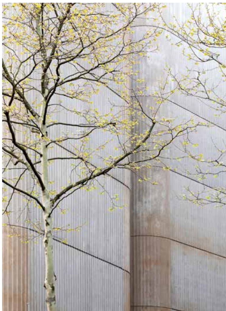
Gesäuberte Betonfassade Rue de Mouzaïa Nr. 58 mit ihrer spezifischen Betonscharrierung
