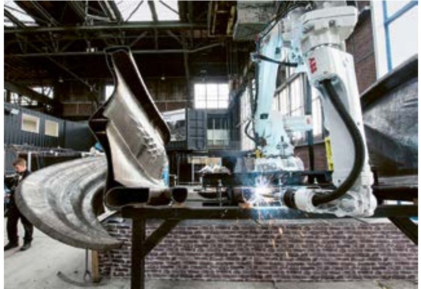
Der von ABB zur Verfügung gestellte 6-Achs-Schweißroboter trägt in einem ununterbrochenen Arbeitsschritt die Stahlschichten der Brüstungsteile und der Hohlstahlprofile des Laufstegs auf.
