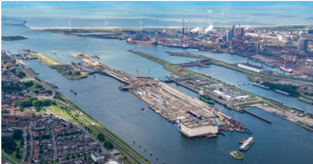
Der bereits existierende Schleusenkomplex bestand aus der Südschleuse (Zuiderluis) von 1876, der mittleren Schleuse (Middensluis) von 1896, der Nordschleuse (Noordersluis) von 1929, der Entwässerungsschleuse (Spuisluis) von 1940 und dem Schöpfwerk (Gemaaal) von 1975. Foto: Topview Luchtfotografie
