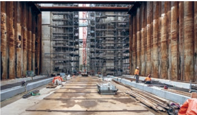
Die 26 m bzw. 55 m breiten, 81 m langen und 4 m dicken Bodenplatten der Torkammern wurden in 4 Abschnitten von ca. 18 m gegossen. Die Wände, mit Dicken bis zu 7 m, wurden ebenfalls in 4 Abschnitten und fünf bzw. sechs Lagen gegossen. Foto: Gerrit Serne
