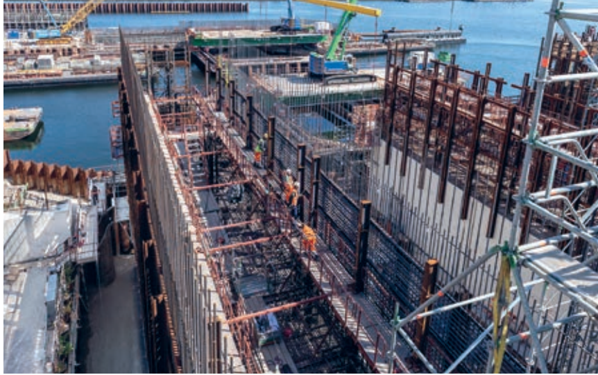
Die Baugruben der Schlitzwände wurden ausgegraben und mit Bentonit gefüllt, um den Einsturz der Grubenwände zu verhindern. Als die notwendige Tiefe von ca. 35 Metern erreicht war, wurden die im Alaskahafen zwischengelagerten Bewehrungskörbe eingeführt und die Schlitzte anschließend mit Beton gefüllt. Das durch den schwereren Beton verdrängte Bentonit wurde während des Betonierprozesses kontinuierlich abgesaugt und wiederverwendet.
