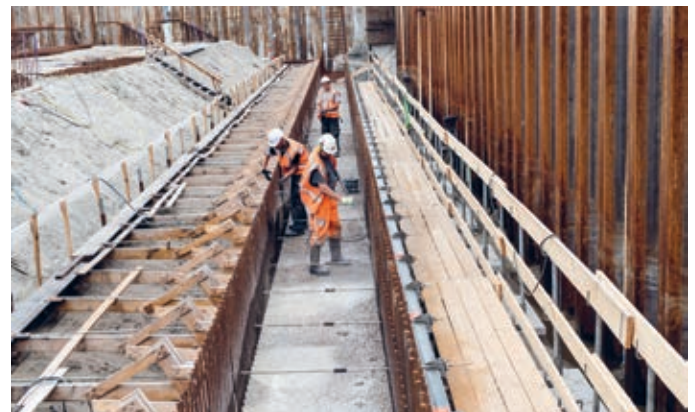
Beton wurde für verschiedene, unter der Wasseroberfläche gelegene Bereiche der Schleuse benötigt wie z.B. für den Boden der Baugrube des Außenkopfs. Dieser ist 4 m dick und wird – gemessen am Amsterdamer Pegel – etwa 20 m unter den Meeresspiegel versenkt. Bei der Passage der Schiffe sorgt der Betonboden vor den Schleusentoren dafür, dass nicht zu viel Sand aufgewirbelt wird und hierdurch keine Strudel entstehen. Foto: Gerrit Serne
