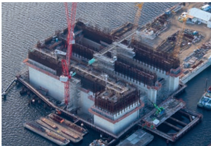
Die Wände der neuen Schleuse liegen +8,85 m über dem Amsterdamer Pegel, dem sogenannten Normaal Amsterdams Peil (NAP), wobei der 0 m Punkt ungefähr dem durchschnittlichen Meeresspiegel der Nordsee entspricht. Mit dieser Höhe übernimmt die Schleuse eine wichtige Funktion als Wall gegen Sturmfluten auch unter Einbeziehung des steigenden Meeresspiegels. Foto: Topview Luchtfotografie
