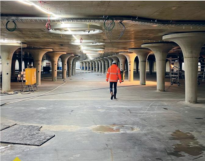
Die Garage im Rohbau mit der Kolonnade der Tropfsäulen in Richtung Westen zum Ausgang zur Metro-Verteilerhalle. An der Decke bereits die ersten Installationen, unter anderem auch für die zukünftigen Verlichtungselemente die sog. „Oculi“. © Frank Naumann, Max Bögl Nederland B.V.
